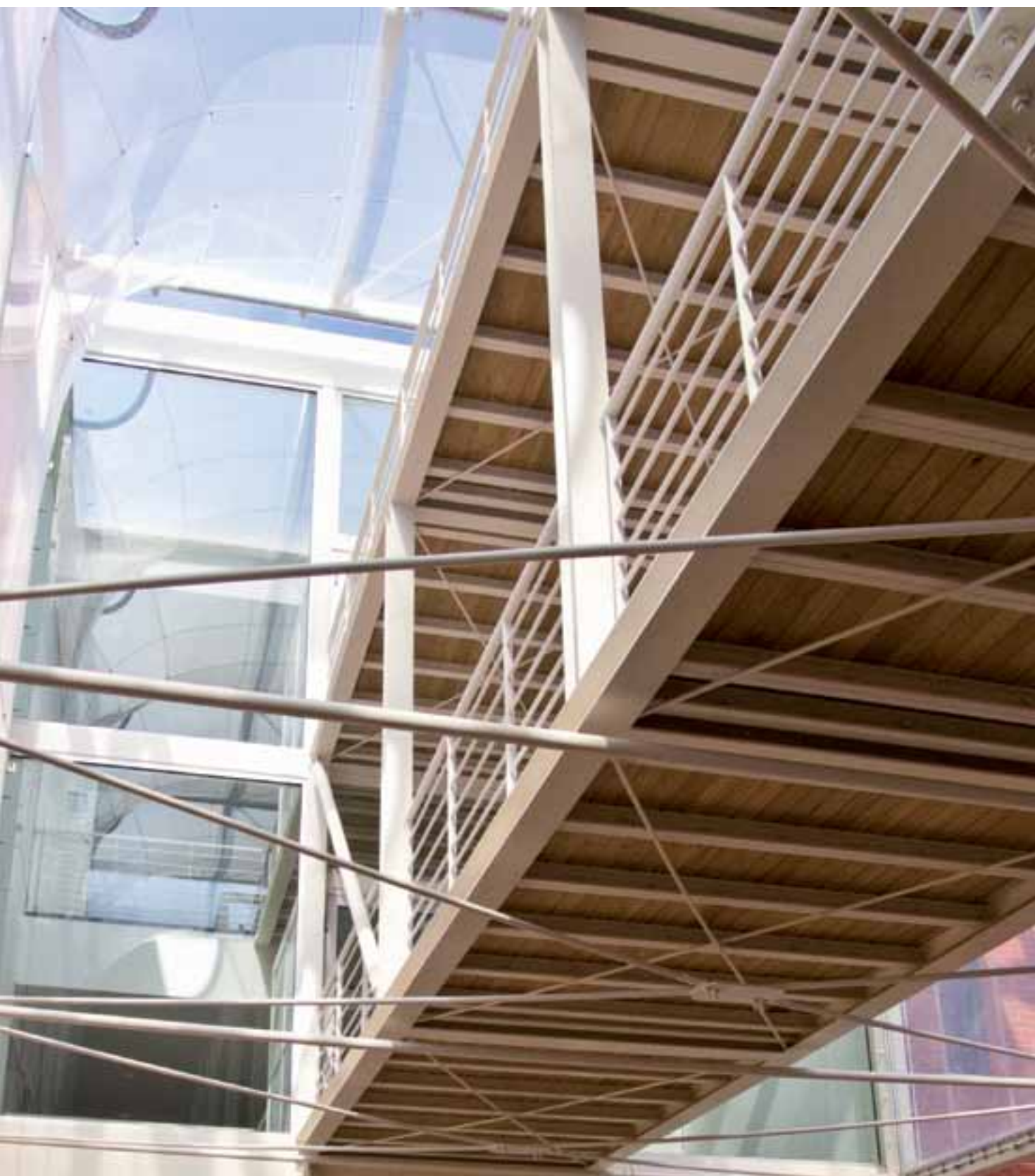
Edifício para a Escola Superior de Saúde da Universidade de Aveiro (Nova Escola de Saúde), Aveiro
