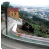
Remodelação da Estrada da Serra, Portalegre
