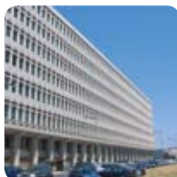
Reparação das Fachadas e Cobertura do Palácio da Justiça de Lisboa, Lisboa
